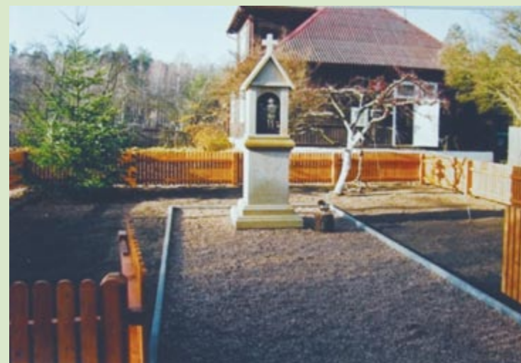
Fot. 53. Kapliczka św. Huberta po zakończeniu budowy, 2006 r.
